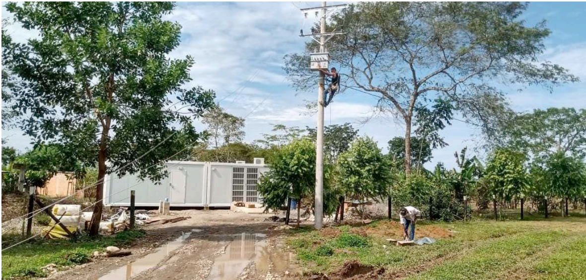
FUENTE: INFORME PNUD 2022. UNIDAD MÓVIL PARA TRANSFORMACIÓN DE CACAO – PLÁTANO ENERGIZACIÓN CONECTADA A LA RED NACIONAL.
